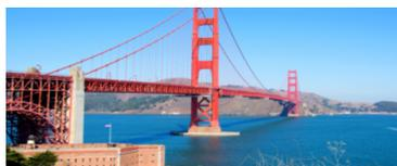
**Estructuras colgantes:** utilizan cables y tensores que se fijan a muros o torres las cuales permiten soportar grandes pesos. Las más conocidas son los puentes colgantes y algunos andamios.
